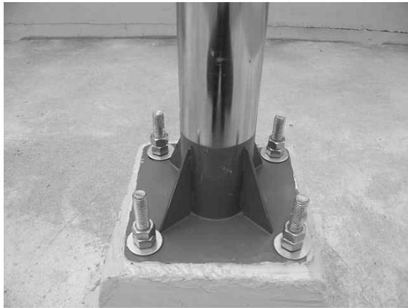
[그림 4-5] 지상파 ANTENNA POLE BASE설치
